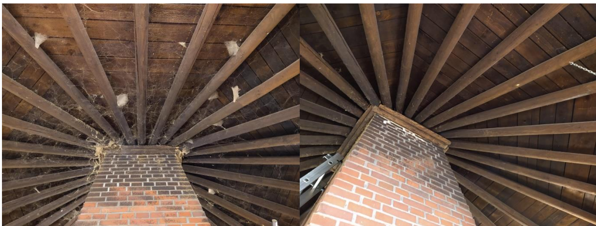
Das Dach der Schutzhütte vorher
