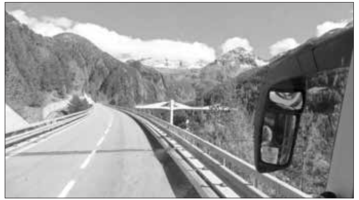
Ganterbrücke Simplonpass / Schweiz
