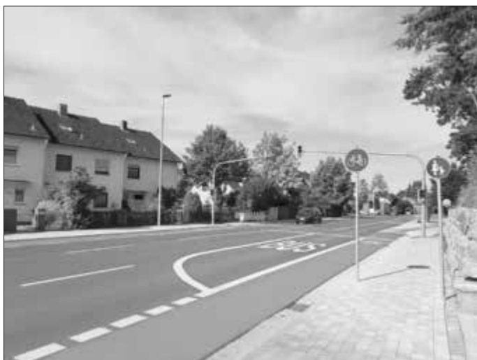
Ein weiteres Praxisbeispiel: eine Verkehrslösung aus der Gemeinde Uttenreuth bei Erlangen. Gezeigt wird eine einladende und konfliktarme Infrastruktur für alle Verkehrsteilnehmenden Foto: Thomas Schuhmacher/Kreisverwaltung
